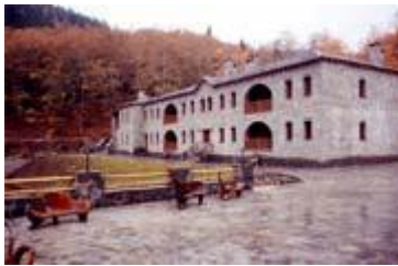
Η ρεσεψιόν του ξενοδοχείου Αχελωΐδες. Το εξωτερικό του ογκώδους κτιρίου φέρνει στο νου το μοναστηριακό στυλ.
